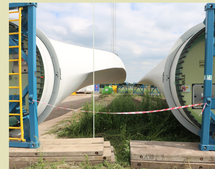
Per windturbinelocatie komen drie rotorbladen naast de kraanopstelplaats te liggen
